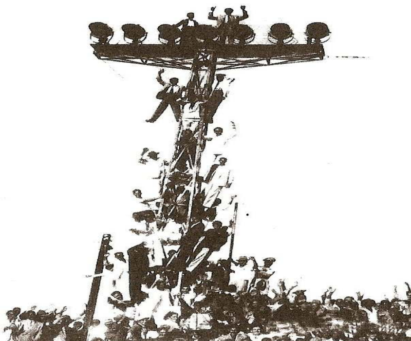
FIG. 33 – Torcedores atleticanos sobre a torre de iluminação do estádio Antônio Carlos.
